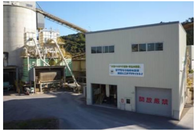
写真4 木質チップ破砕機&投入設備
