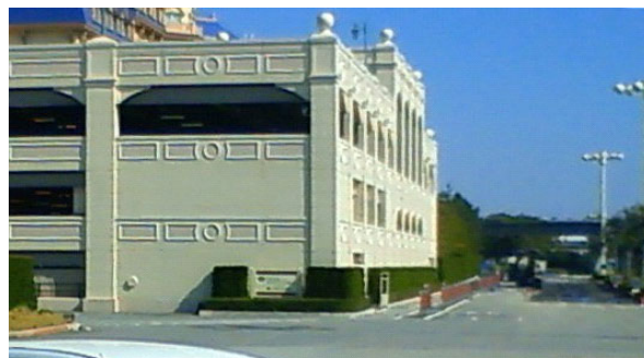
写真 4.4.1 地震後の立体駐車場 (2011.3.13 撮影)
