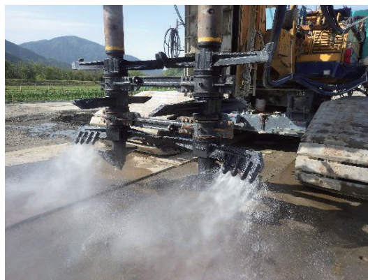
写真 2 セメントスラリー吐出状況 2)
