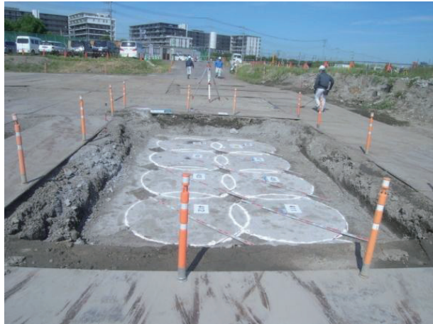
写真 3 杭頭の出来形管理状況
