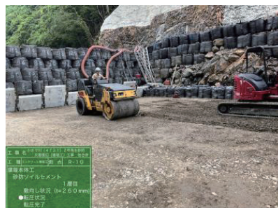
写真7 本体工・転圧状況
