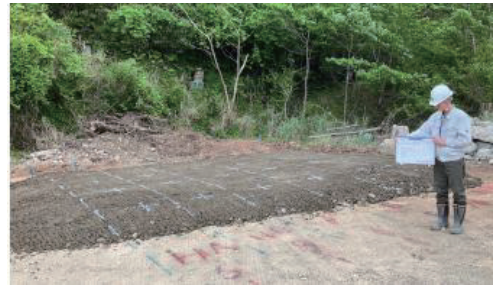
写真3 試験施工ヤード・敷均し完了
