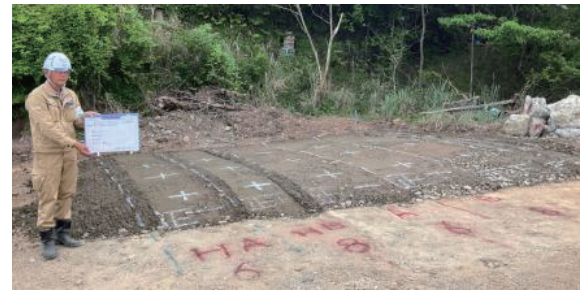
写真5 試験施工ヤード・転圧完了
