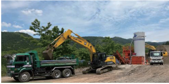
写真2 INSEM 材製造プラント・運搬状況
