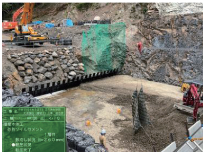
写真6 本体工・敷均し状況
