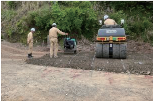
写真4 試験施工・転圧状況
