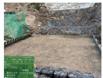
写真8 本体工・転圧完了
