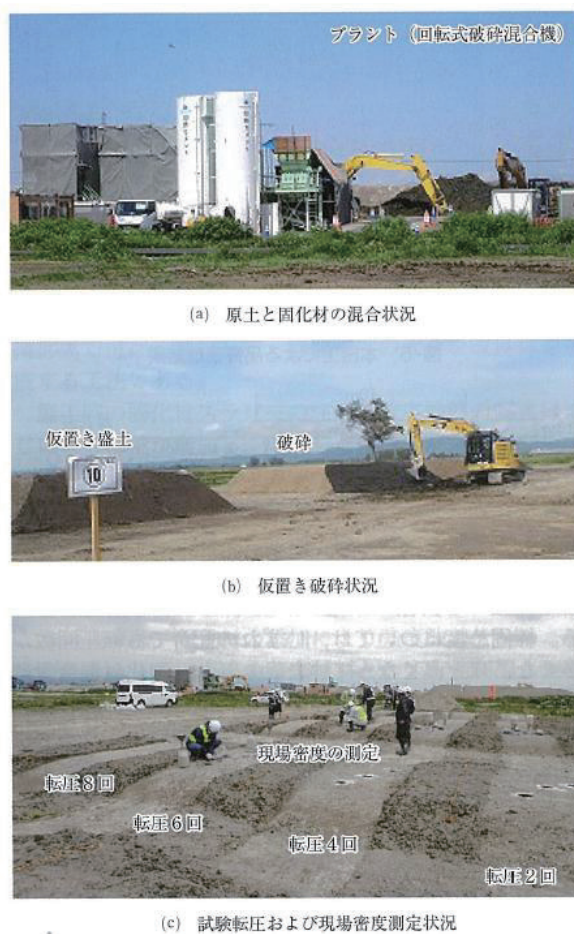
写真 2 試験施工の状況 2)
