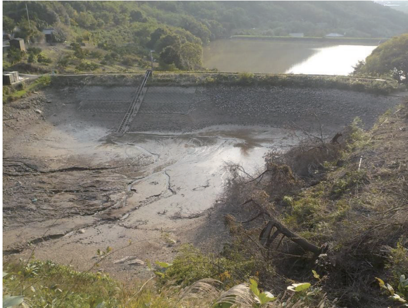
写真 2 排水後の奥池上池
