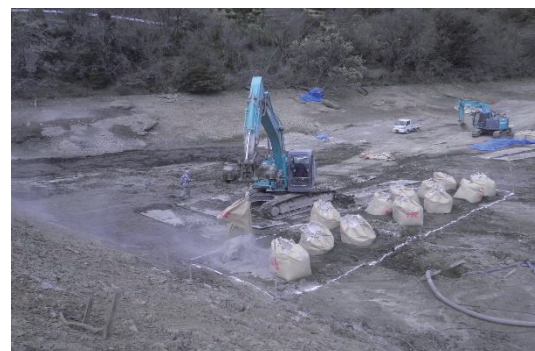
写真 4 固化材の散布
