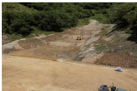
写真 8 施工後の様子
