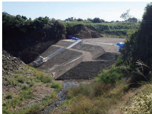
写真4 盛土の整備状況（その2）
