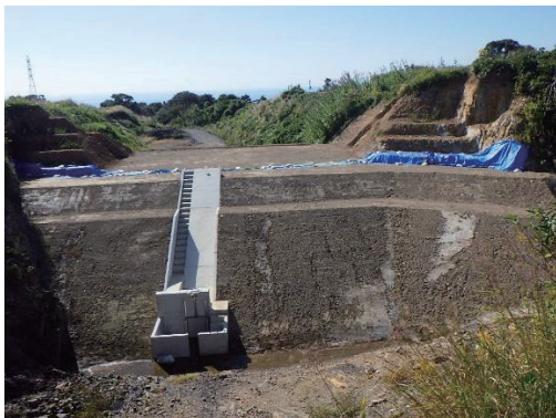
写真3 盛土の整備状況（その1）
