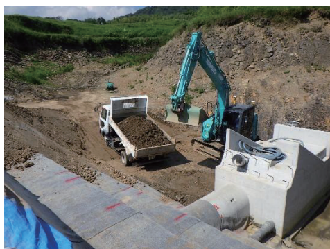
(c) 改良した盛土材の運搬
