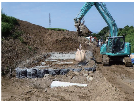
(a) 混合攪拌ヤードでの固化材散布
