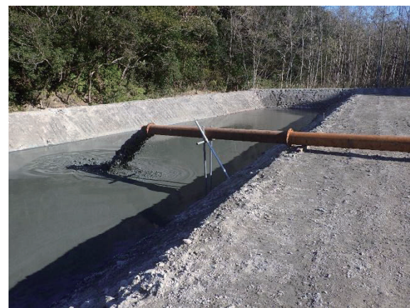
写真 10 濃縮土の圧送・貯蔵状況 (H31 養生ヤード)
