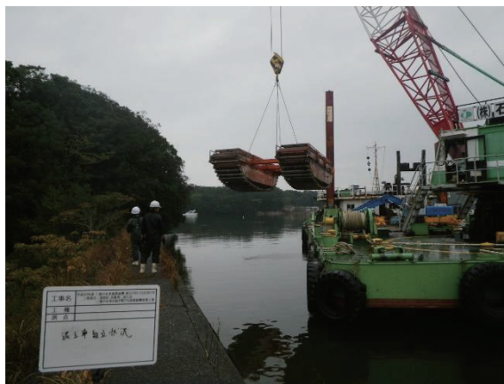
写真 9 泥上車の組立状況
