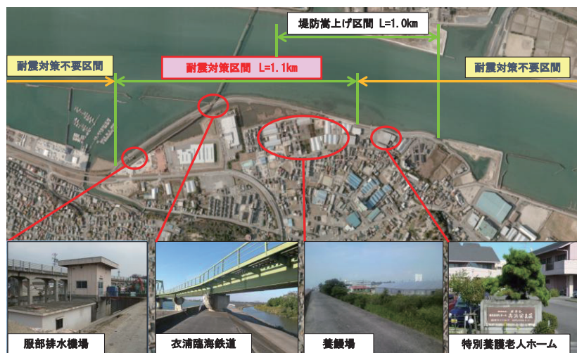
写真 1 耐震対策工事の範囲
