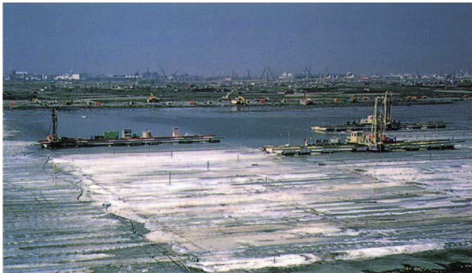
写真1 横行式連続処理船による施工の様子
