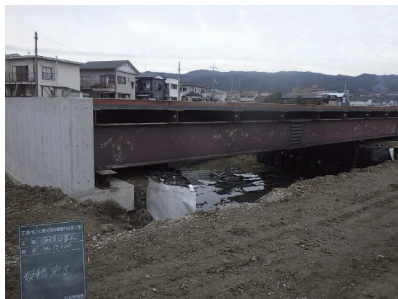
写真 3 仮橋の設置状況
