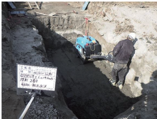
(c) 転圧状況（その 1）
