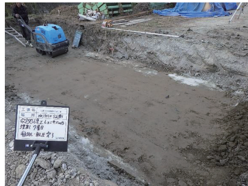
(d) 転圧状況（その 2）
