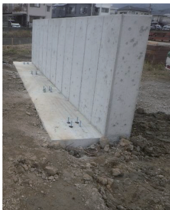
写真 2 橋台の設置状況
