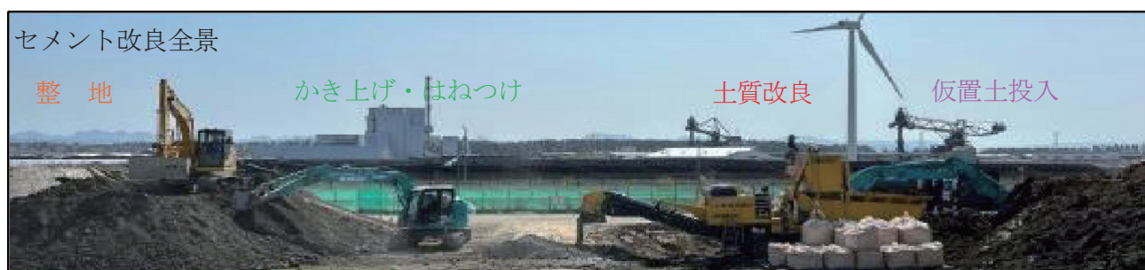
写真3 セメント改良全景
