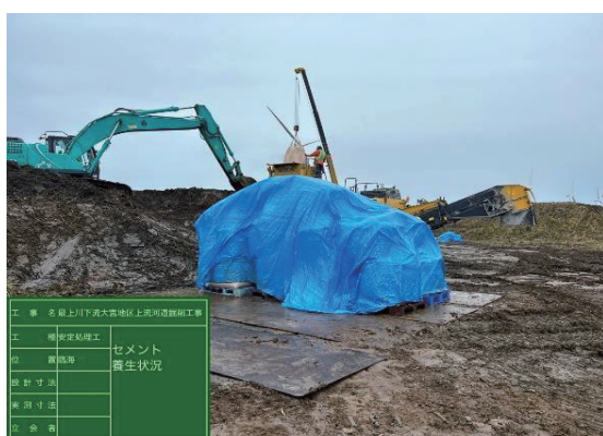
写真 4 ブルーシート養生
