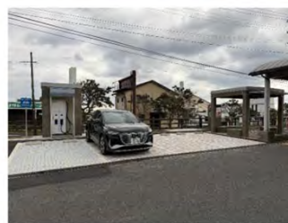
EV 急速充電ステーション全景
